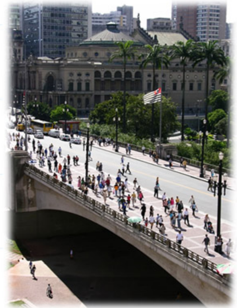
Viaduto do Chá (SP)
